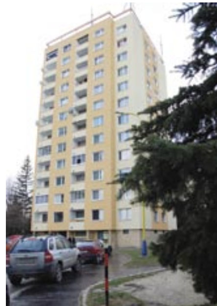
Zateplenie prinieslo úsporu tepla, ale zmenilo aj vonkajší vzhľad bytovky.
